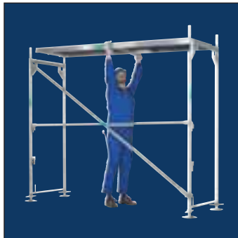
Vertikaldiagonale und Gerüstbelag einbauen
