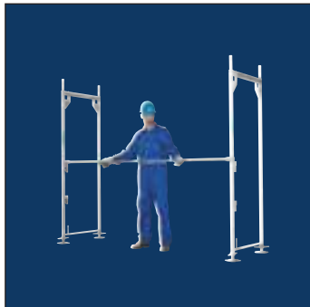
Vertikalrahmen aufstecken und mit Geländerholm sichern
