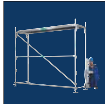
Längsriegel einbauen und Gerüstfeld ausrichten
